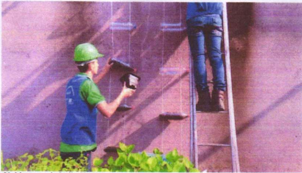
Imagem 20: Montagem do Jardim Vertical Fonte: Jéssica 2016
